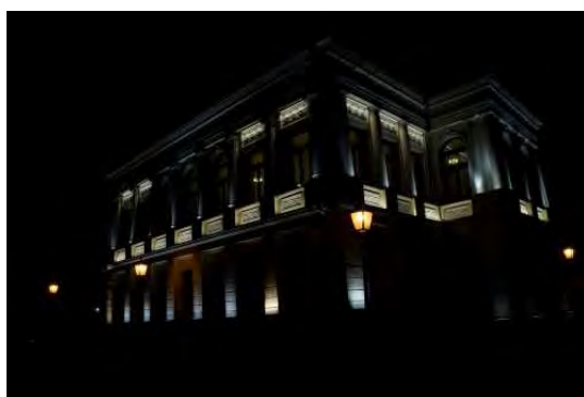
Figura 58 Fațada Muzeului Municipal , cu timp mai scurt de expunere, pentru gamă dinamică ridicată
