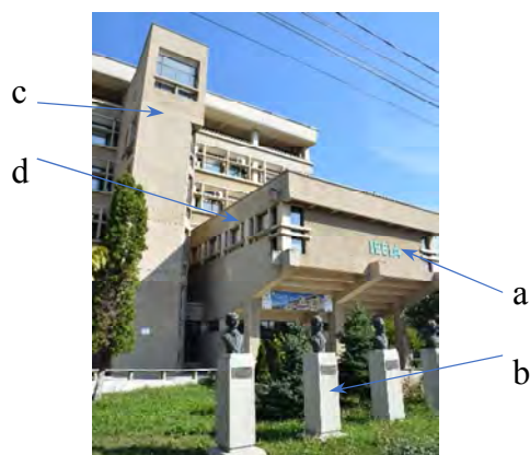
Figura 82 Facultatea de Inginerie Electrică din Iași cu detalii pentru iluminatul arhitectural: a) sigla; b) statui; c) turn; d) ramele ferestrelor
