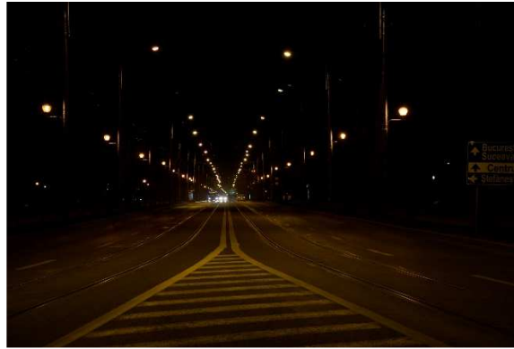
Figura 185 Sistemul de iluminare de pe bulevardul Carol, Iași
