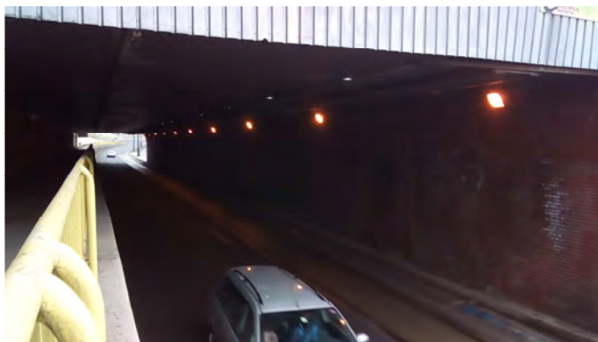
Figura 6 Tunelul TMK de la Reșița - una dintre cele două direcții de circulație cu două benzi pentru mașini și trotuar pentru pietoni
