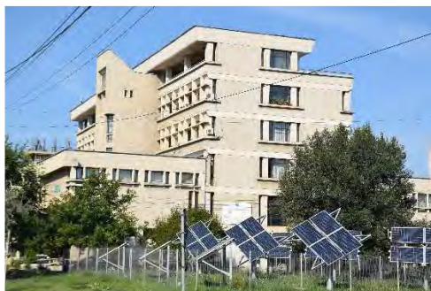
Figura 81 Facultatea de Inginerie Electrică din Iași cu panouri fotovoltaice
