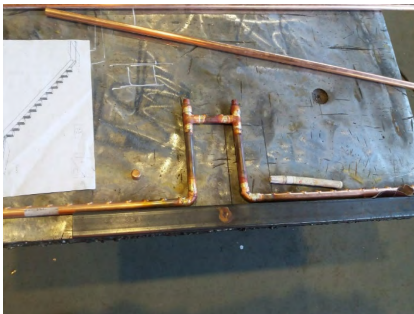
Figura 5.15. Execuția distribuitorilor și colectoarelor
