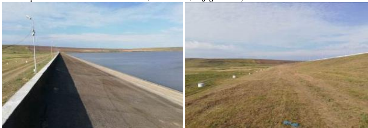
Figura 4.2 – Vedere taluz amonte și taluz aval corp baraj
