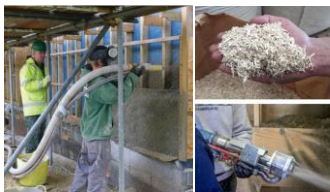
Figura 2.3 Aplicarea mecanizată a betonului de cânepă [82]
