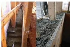
Figura 2.1 Beton de cânepă turnat în sistem monolit [78], [79]
